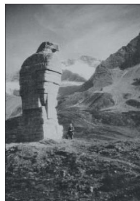
Abbildung 14: E.F. Baumann neben seinem Adlerdenkmal (Paul Baumann 1947)
