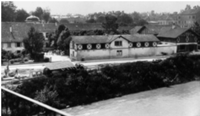
Abbildung 4: Ansicht der Tierarzneischule Zürich vor dem Umbau der Anatomie (von Westen her, also der Sihlseite her gesehen). Links das «Scharfrichterhaus», in der Mitte der Pferdestall und rechts davon das «Tierspital», von Bäumen verdeckt das Anatomiegebäude.
